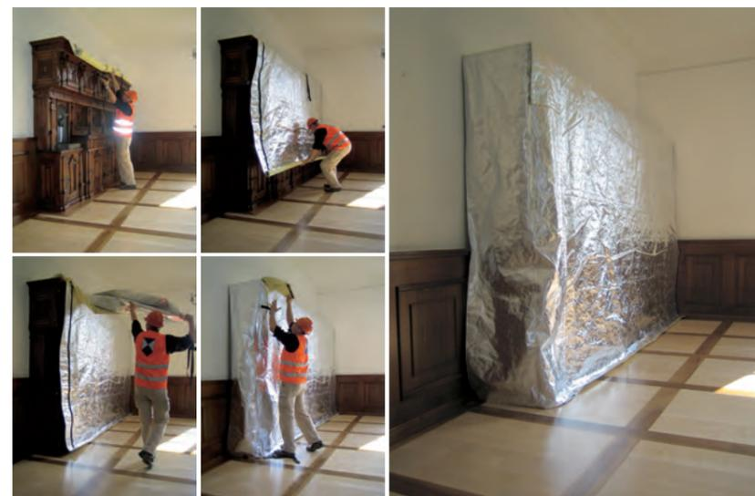
**Mass-Brandschutzhüllen** werden individuell konzipiert, gefertigt und deren Handhabung in der Regel in eine CURESYS KGS-Notfalleinsatzplanung integriert. Die Brandschutzhüllen werden vor Ort installiert.
