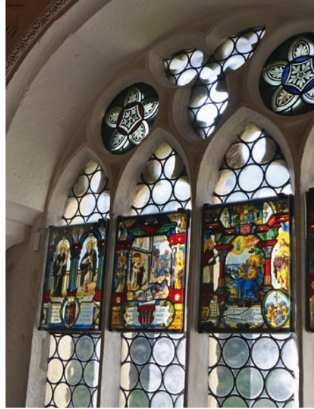
Links: Gefährliches Gewölbe: Über der Kuppel kann sich Löschwasser sammeln und die Decke zum Einsturz bringen. Rechts: Die Glasmalereien im Kreuzgang des Klosters reagieren empfindlich auf Druck. Deshalb ist beim Löschen Vorsicht geboten.
