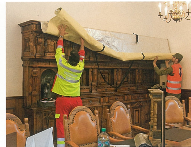
Abb. 4 und 5 Die beiden historischen Buffets im Obwaldner Rathaus: Während sich das eine mit wenigen Handgriffen demontieren und evakuieren lässt, wird das fest eingebaute mit einer fix installierten Brandschutzdecke geschützt.
