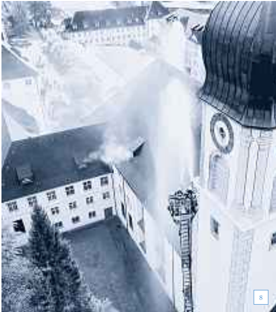
8 Rauch von innen und Löscheinsatz durch die Feuerwehren von aussen. Foto: © Tobias Diller (OW) / CURESYS AG.
